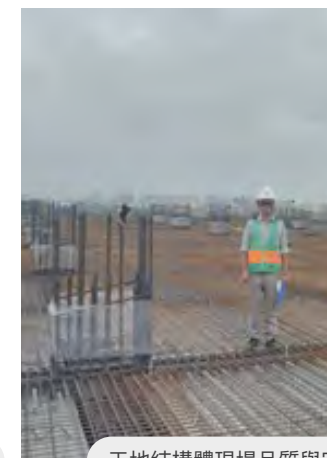
工地結構體現場品質與安全
