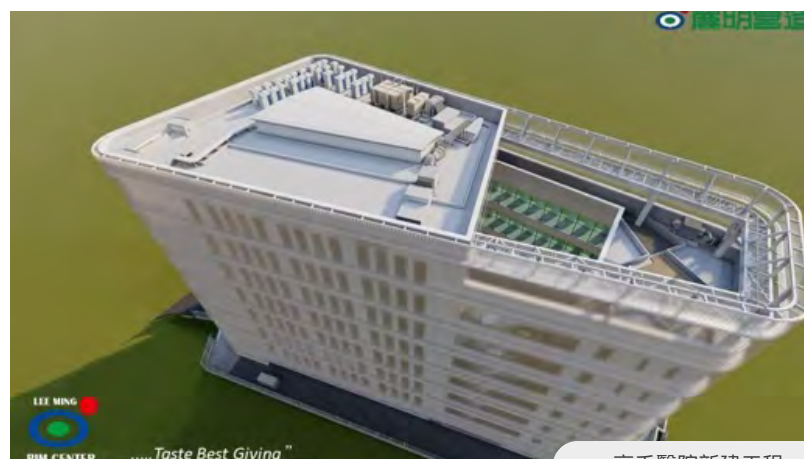
高禾醫院新建工程
