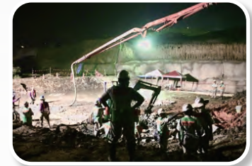
2020.05.20 首度取得台灣積體電路股份有限公司研發大樓新建工程
