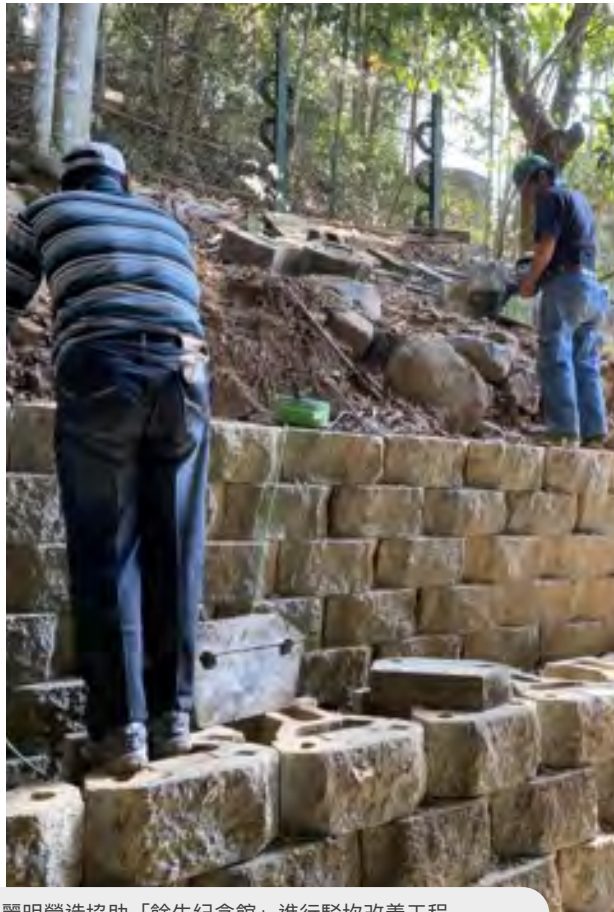
麗明營造協助「餘生紀念館」進行駁坎改善工程
