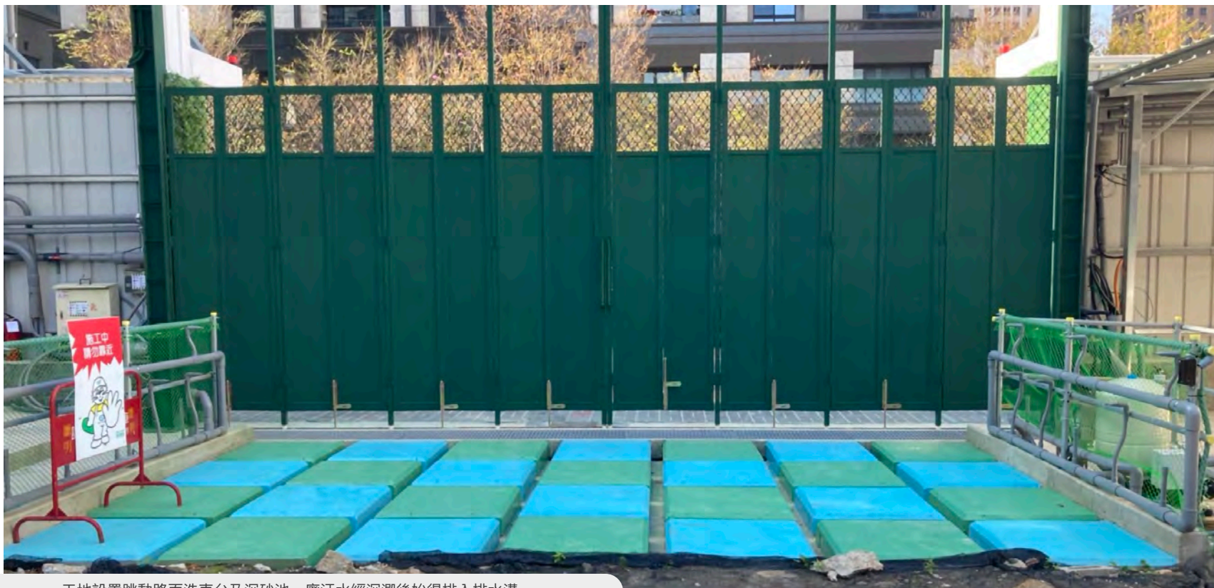
工地設置跳動路面洗車台及沉砂池，廢汙水經沉澱後始得排入排水溝。
