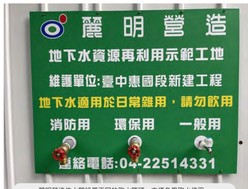
麗明營造依水質設置不同的取水龍頭，方便各界取水使用。
