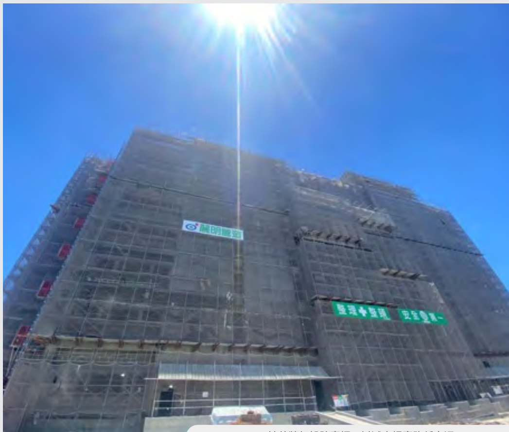
工地外牆架設防塵網，以減少揚塵降低空汙。
