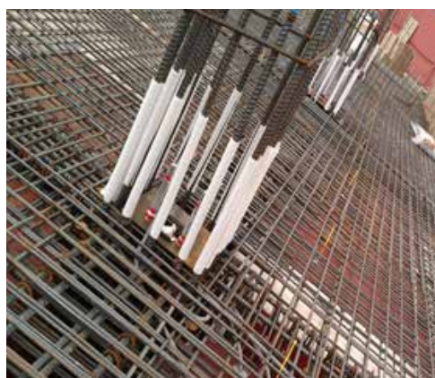
▲ 澆置前鋼筋確實防護避免汙染
