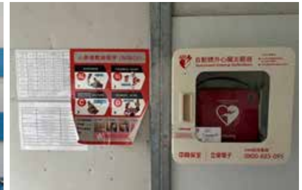
▼ 於示範工地裝設 AED
