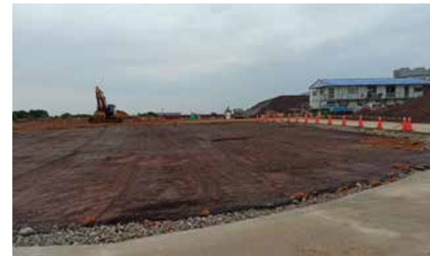
裸露地表覆蓋防塵網以抑制粉塵逸散、減少揚塵
