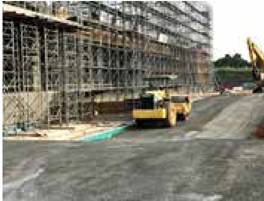
採用杜邦之鈦鐵礦人造粒料，以抑制粉塵逸散
