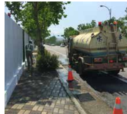
利用水車洗掃工區外圍道路，可有效削減路面髒污及空氣污染
