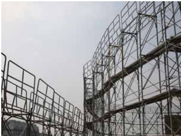
▼ 施工架扶手先行
