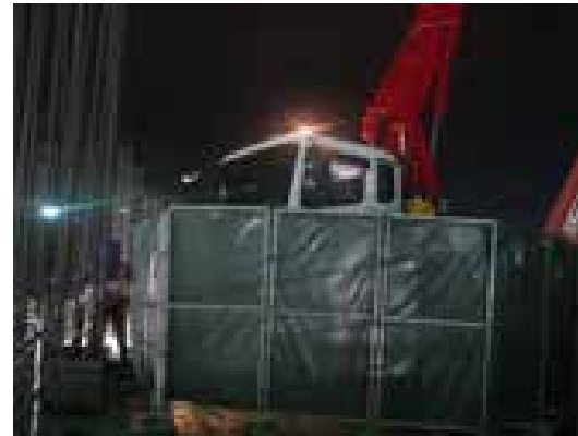
於灌漿作業泵浦車加裝隔音屏，可降低噪音污染，減少社區困擾
