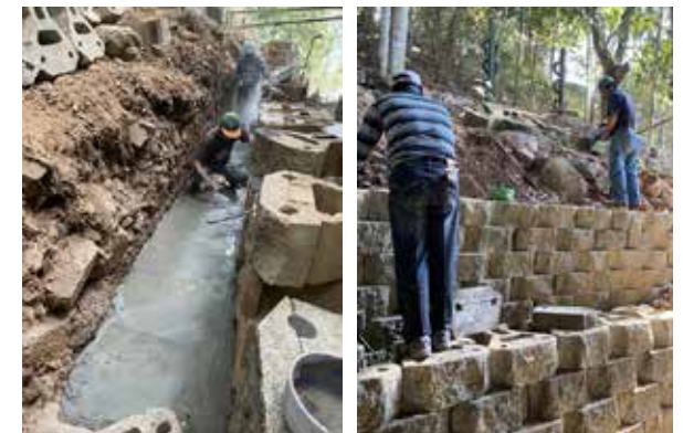
▲ 麗明營造協助「餘生紀念館」進行駁坎改善工程
