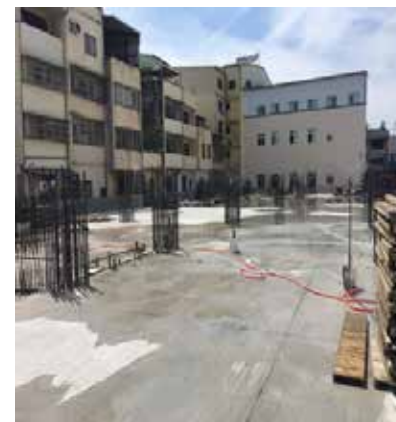
▲ 樓版養護確實設置自動灑水裝置
