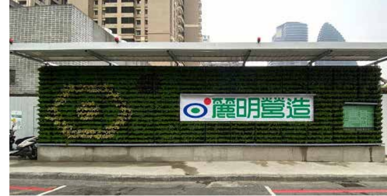
圍牆外圍施作植栽，以美化環境、改善空氣品質
