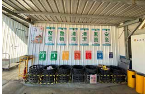
工地內設置分類垃圾桶，達成垃圾減量、提升資源循環使用率
