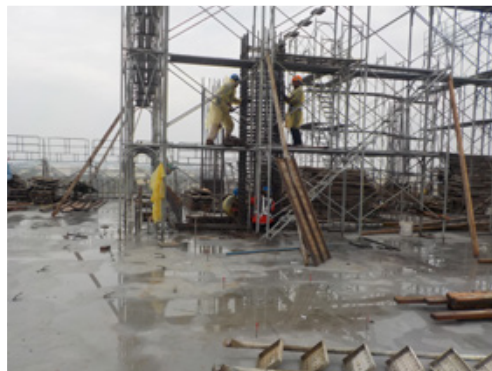
◀ 麗明第 12 屆攝影比賽銀牌「趕工」，描繪優良廠商雖然冒雨趕工，但鋼筋工仍然依循規範穿著雨衣綁紮，顯示麗明對職安的重視。
